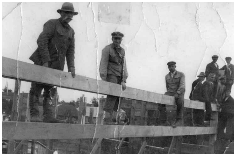
Na budowie. Józef Starościak siedzi na końcu w kapeluszu
